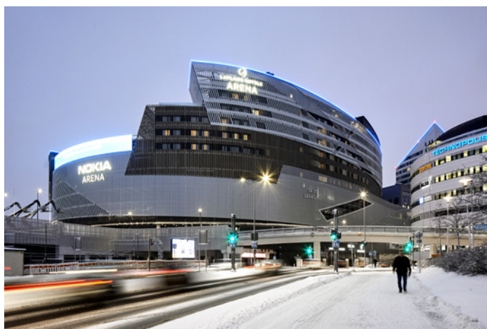
NOKIA Arena - Tampere - Finlandia
