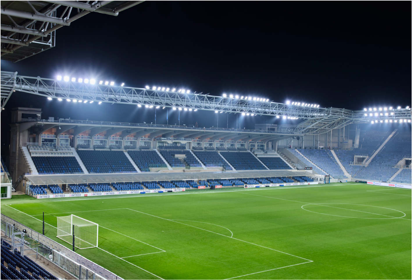
Stadio di Bergamo - Bergamo - Italy
